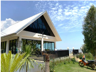
อาคารฝึกอบรมและสัมมนา
